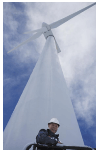
Molly vid Mollösund på Orust - Vindenergi Väst:s första vindkraftverk, rest i september 1993.
